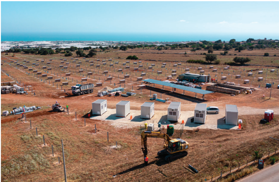
Fig. 2 – Lavori in corso nei 5 ettari da adibire per l'agri-voltaico, nel maggio 2022. Fonte: https://focusicilia.it/scicli-nel-parco-agrivoltaico-energia-solare-per-agricoltura-e-allevamento/ (consultato il 5/12/2022).
