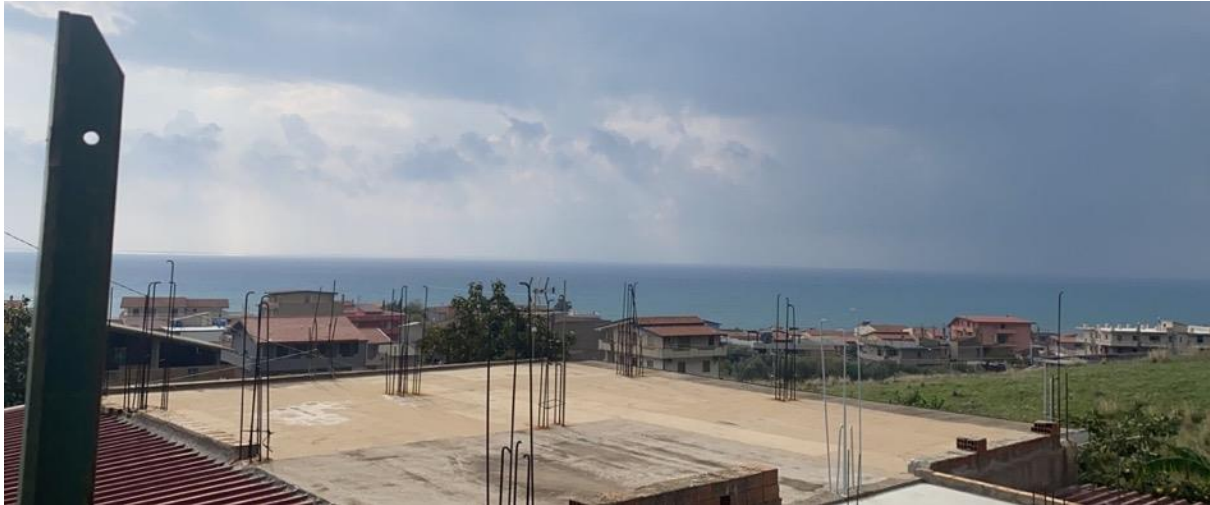
Figura 4.1. Un esempio di ‘costruito non finito’ in Area Grecanica.
